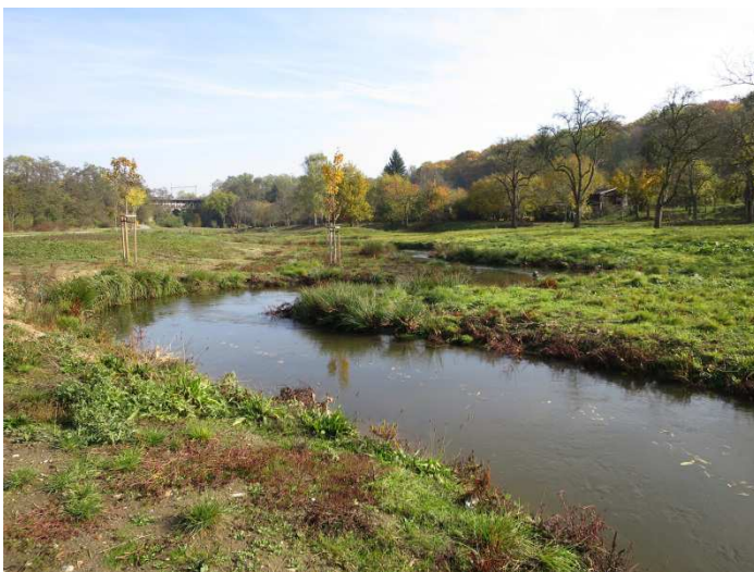
Obr 6 Revitalizované koryto Rokytky s rozvinutou přibřežní vegetací
