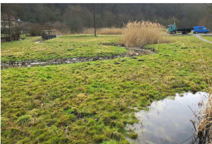
Obr 4 Revitalizované koryto Šáreckého potoka s neprůtočnou tůňí
